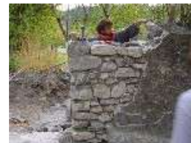
Réalisation de l'arase et préparation du couronnement.
