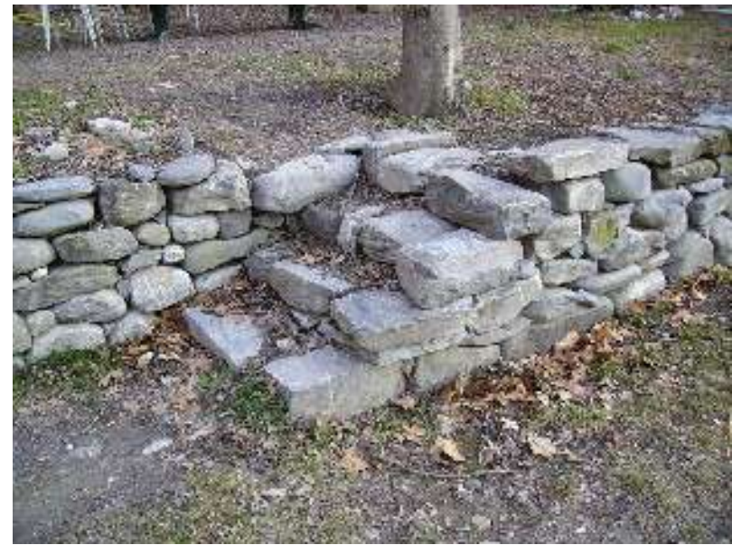
Mur et escalier en pierre sèche.
