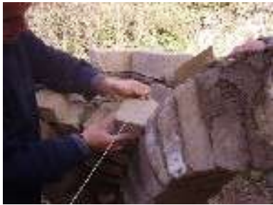
Réalisation d'un pendentif entre deux arcs plein cintre.
