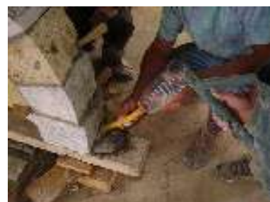
Coulinage en partant du bas jusqu'à refus complet.
