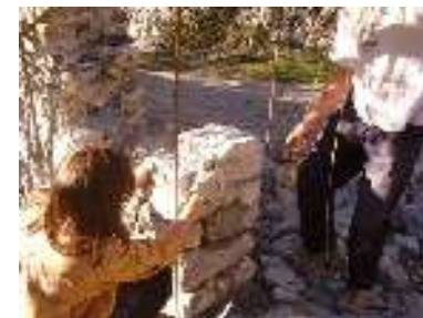
Vérification de l'aplomb de la tête de mur dans les deux directions.
