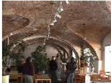
Voûte en panier.
