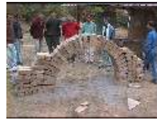
2- après décoffrage on vérifie qu'il est stable.
