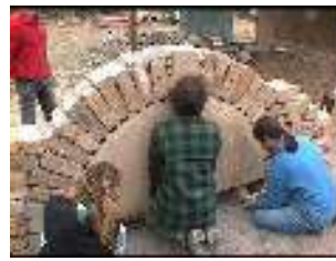
1- l'arc est érigé avec du sable sans mortier et les reins chargés
