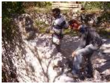
Réparation d'une tête de mur.
