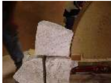
Les pierres sont posées sur cal.
