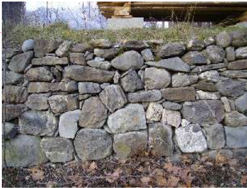
Mur de pierre sèche
