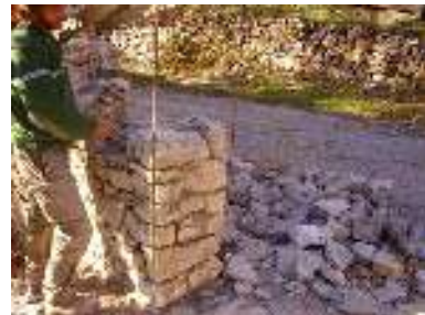
Réparation d'une tête de mur.
