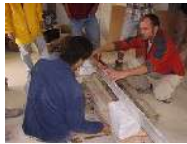
Vérification de l'assise de l'arc.
