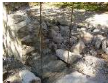
Démontage partiel permettant de recréer un harpage.
