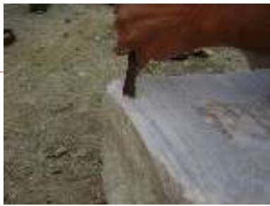
Réalisation d'une ciselure :
