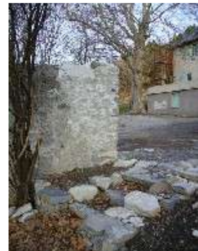
Tête de mur maçonnée et escalier en pierre sèche.
