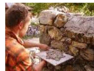
Remplissage des joints au fer à joint.
