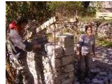
Attention à conserver l'homogénéité esthétique du mur !
