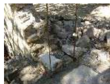
Mise en place de mortier et pose d'un premier lit de pierre.
