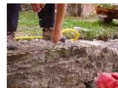
Nettoyage au jet des coulures de mortier.
