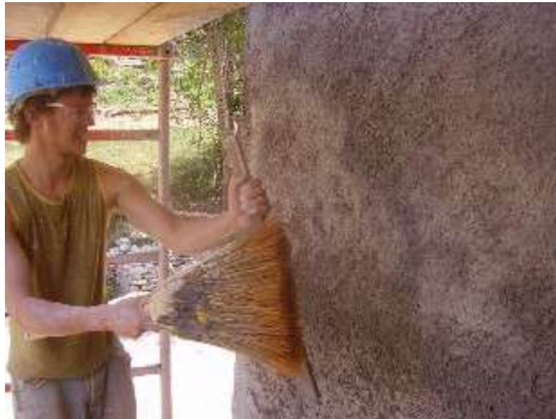
Reconstitution d'un enduit au balai
