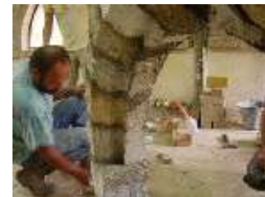
Nettoyage du dessous de l'arc.
