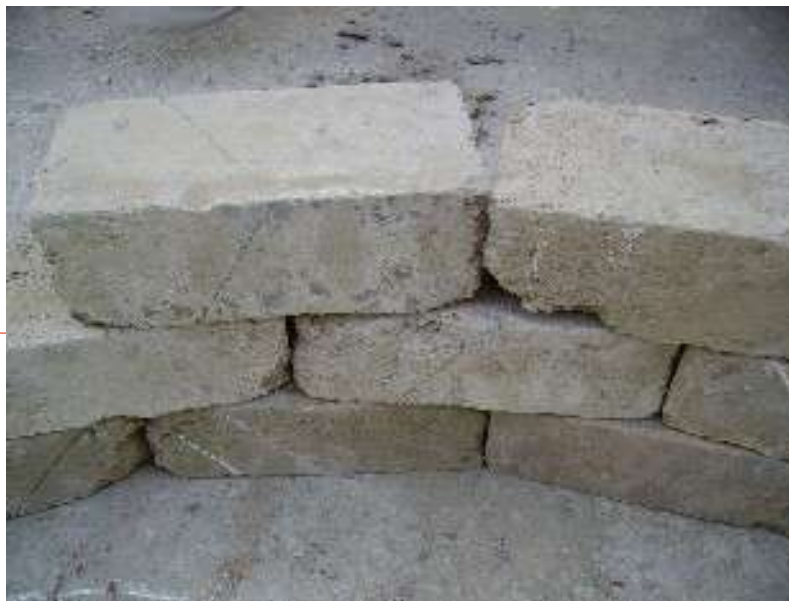
b. Variation de l'inclinaison des assises (D'après CRATERRE 1979)
