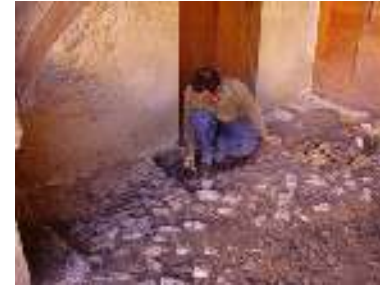
Démontage et remontage des parties affaissées.
