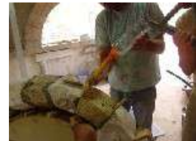
Coulinage : 1 V de Nhl pour 1 V de sable (0,1).
