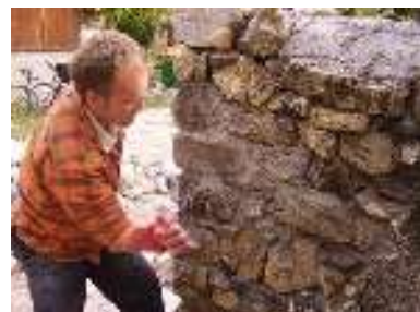
Remplissage des joints à la main.
