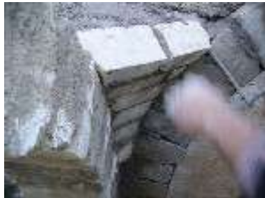
Réalisation d'un pendentif entre deux arcs plein cintre.
