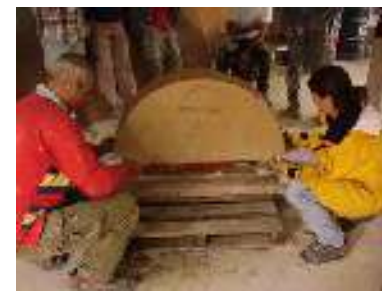
Mise en place du cintre
