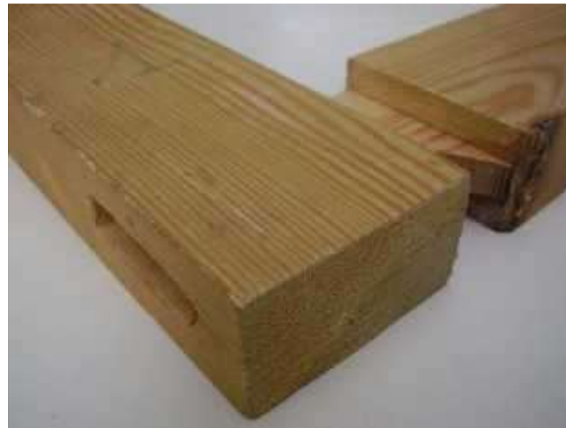
Assemblage par tenon mortaise avec renfort d'épaulement.
