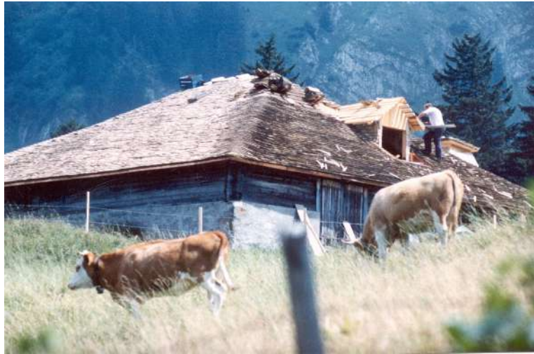
Photo 29 ) Chantier Olivier Veuve - suisse
