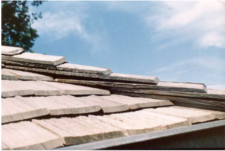
Détails d'une rive
