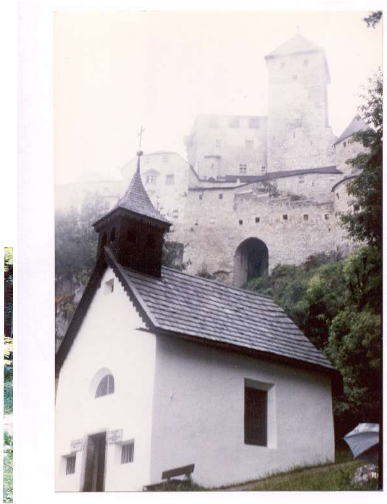
Photo 15 ) Château deTAUFERS (italie) SUD TYROL, entièrement recouvert d'Ancelles
