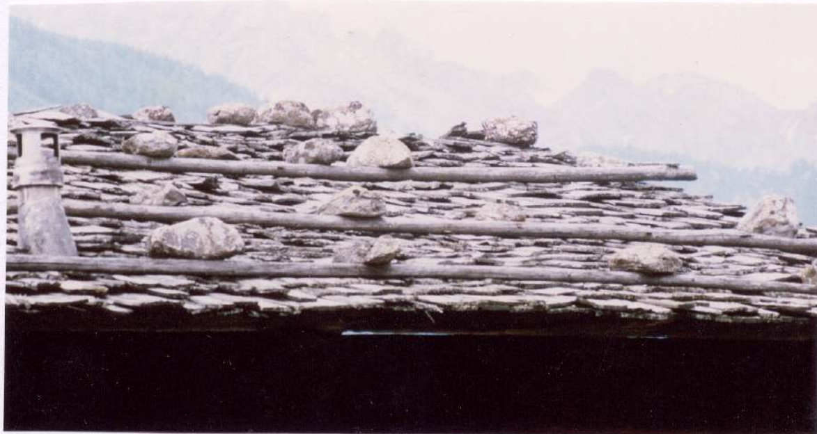
PHOTO 3) pierres et perches maintenant les ancelles en place
