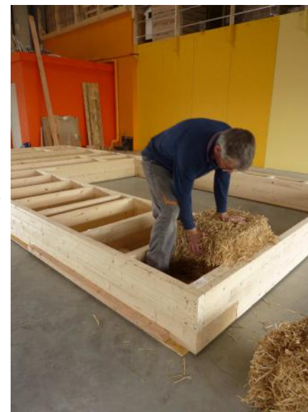
Mise en place d'une botte pleine de dimensions 45 x 45 x 36cm
