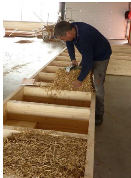
Mise en place d'une botte plus petite
