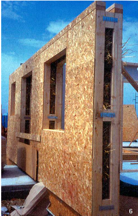
Exemple de levage sur le chantier de murs préfabriqués en paille
