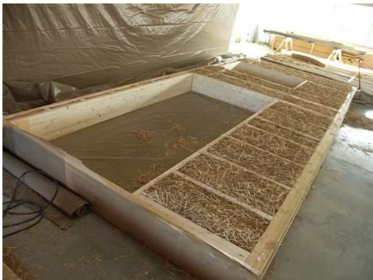
Mur à ossature bois pré-fabriqu  par Charpente C nomane
