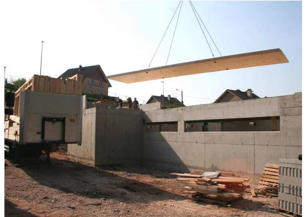
Exemple de levage d'une dalle bois KLH
