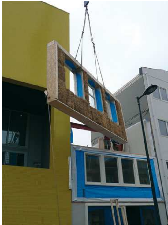
Exemple de levage sur le chantier de murs préfabriqués en paille
