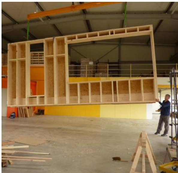
Mur à ossature bois pré-fabriqu  par Charpente C nomane
