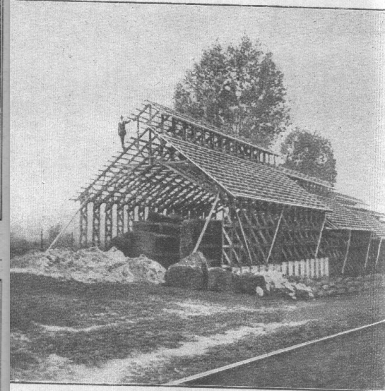
UN BATIMENT INDUSTRIEL EN COURS DE CONSTRUCTION
