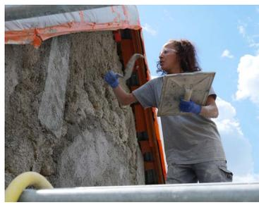
Mission : restauration globale de la façade : décroûtage de l'ancien enduit, gobetis, corps d'enduit, enduit de finition à la chaux
