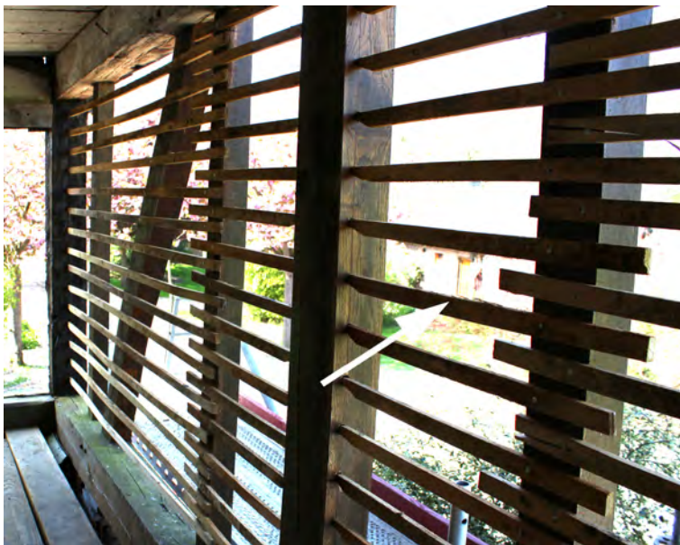
Illustration 16: Lattage formant lattis par endroit (Yan Minne)
