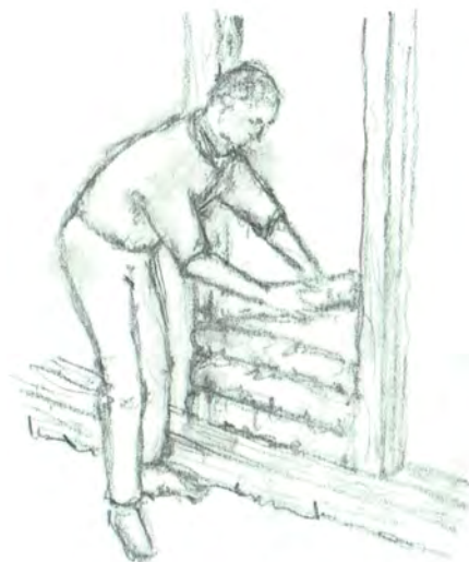
Illustration 29: Les fuseaux juxtaposés sont placés frais dans les cadres des colombages. Finition d'égalsation avec un enduit ou forme de torchis plaqué.
