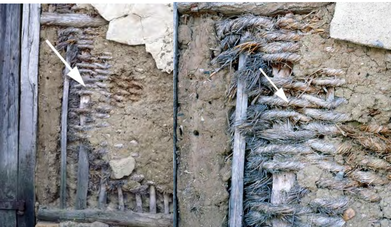
Illustration 20: Détail. La paille est torsadée directement ou après trempage dans une barbotine de terre, puis elle est tressée sur la première trame. (Choplain Roger; Maston Roland)
