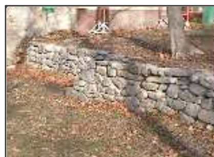
mur de pierres sèches stage Le Gabion (doc.Le Gabion)
