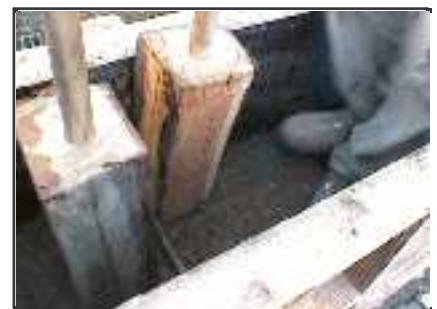
compactage (doc. Le Gabion)
