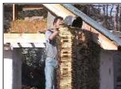
remplissage (doc. Le Gabion)
