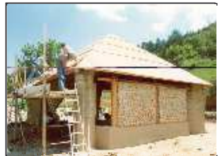
chantier abris du mélèze (doc. Le Gabion)
