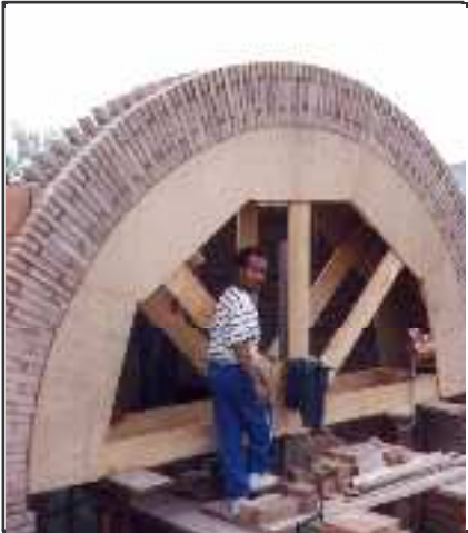
arc sur coffrage stage Le Gabion (doc.Le Gabion)
