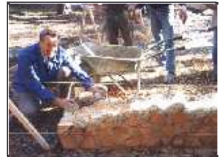
mur test (doc. Le Gabion)
