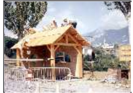
chantier abris bus (doc. Le Gabion)
