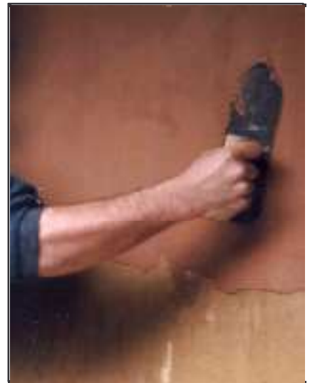
mise en œuvre (doc. Le Gabion)
