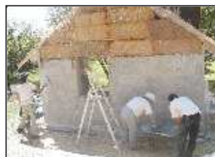
pose de l'enduit stage Le Gabion (doc.Le Gabion)
