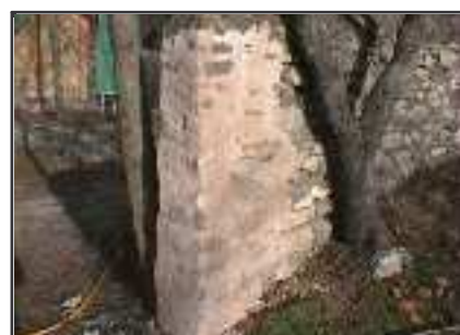
sur mur de pierre stage Le Gabion (doc.Le Gabion)
