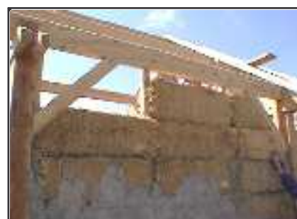
mur extérieur (doc.Le Gabion)
