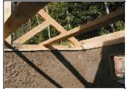
enduit terre ragréage (doc. Le Gabion)
