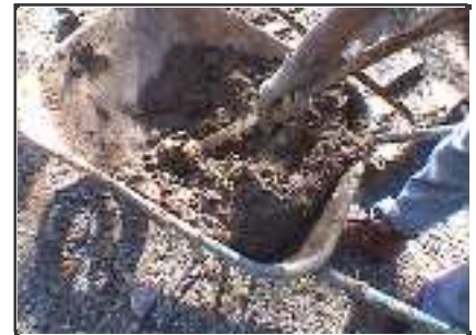
mélange terre/fibres (doc.Le Gabion)
