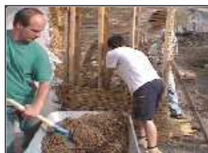
remplissage (doc. Le Gabion)
