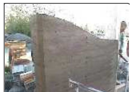
après le rait des banches stage Le Gabion (doc. Le Gabion)
