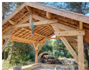
Module charpente à Meyrargues
