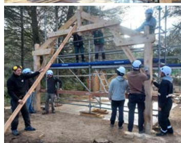
Module charpente à Meyrargues
